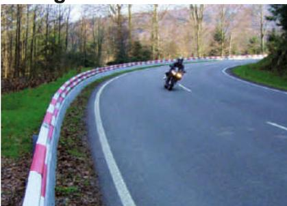
Mejora considerablemente la visibilidad de las curvas de la carretera. Fabricado en plástico coloreado, flexible, para adaptarse fácilmente a la forma de la barrera. Ligero, resistente y duradero. No presenta ningún peligro para el usuario en caso de choque. Incorpora bandas retro-reflectantes de nivel III. Fácil instalación.
